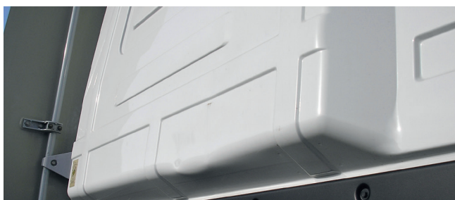
✓ Paroi arrière de la cabine/ Traces d'usure • Griffes et éraflures légères, petites bosses
